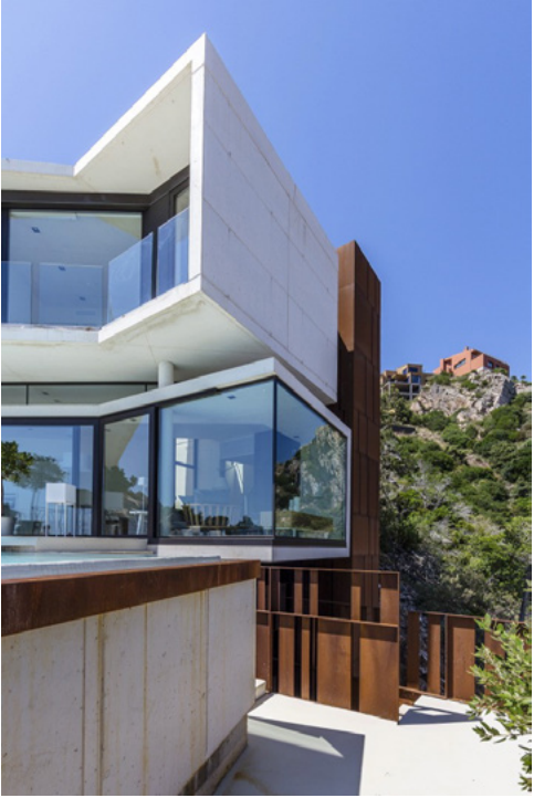
Vista des de la terrassa inferior. Vista desde la terraza inferior. View from lower terrace.
