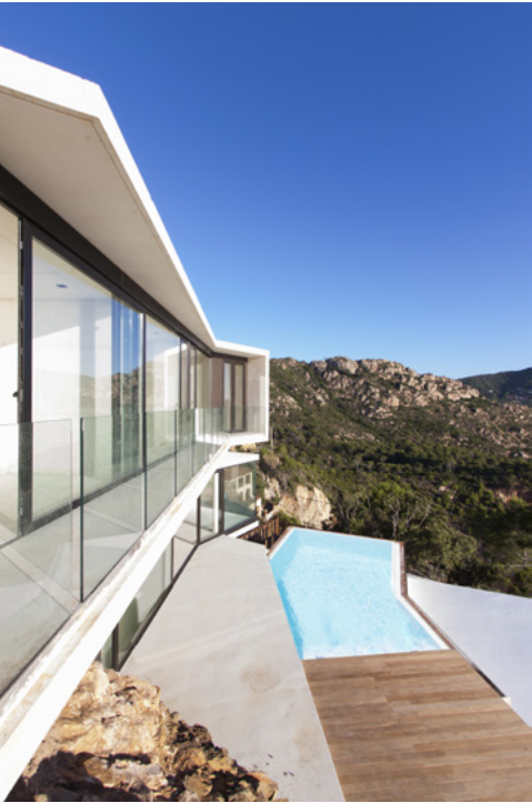
Façana oest des del balcó. Fachada oeste desde el balcón. West façade from balcony.
